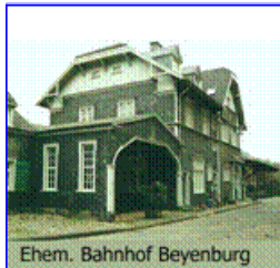
Ehem. Bahnhof Beyenburg
